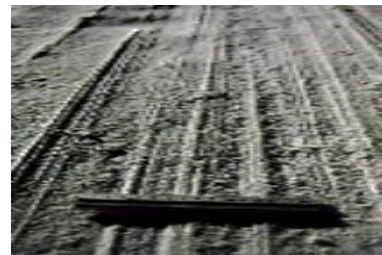
Surface de route d'un tronçon avec démarrages et arrêts pour un taux d'équipement en pneus cloutés de 20 %
