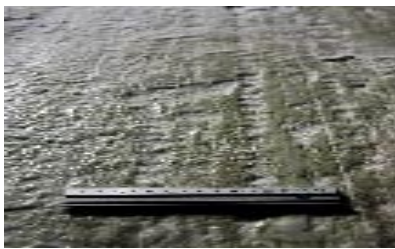
Surface de route d'un tronçon avec démarrages et arrêts pour un taux d'équipement en pneus sans clous de 100 %
