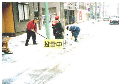
Photo 2: Scène où l'on jette de la neige dans un fossé de neige courante
