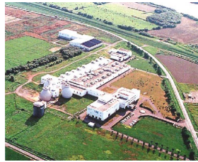
Centre d'épuration des eaux d'égouts de Naié situé dans le bassin de la Rivière Ishikari
