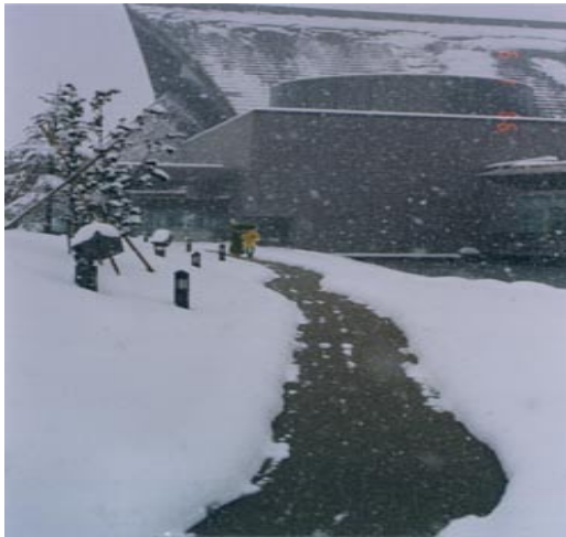
Fig. 15 Etat de la fonte de la neige
