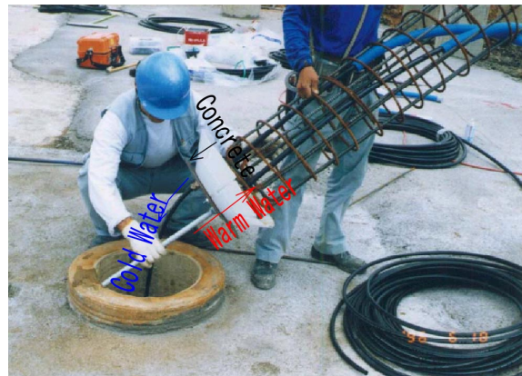
Fig. 12 Travaux près d'un pieu de fondation
