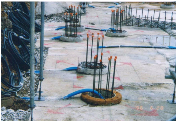
Fig. 13 Travaux auprès de pieux de fondation
