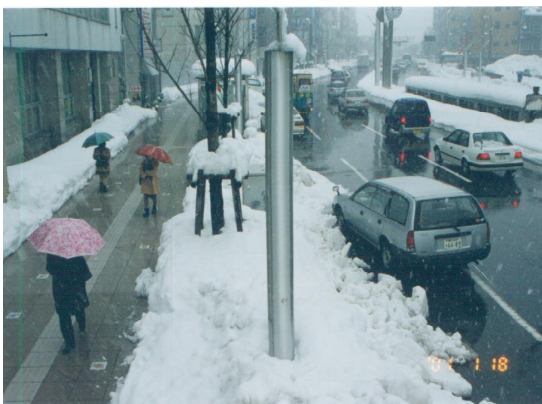
Fig. 3 Vue d'un système de fonte de la neige en cascade, utilisant de l'eau souterraine, dans la ville de Fukui
