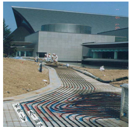
Fig. 14 Installation de tuyaux de dissipation
