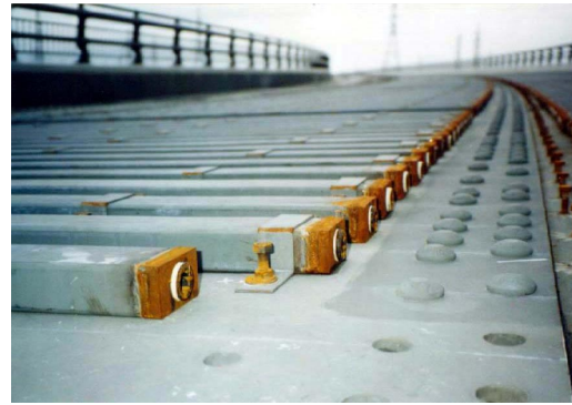
Fig. 22 Tuyaux d'acier remplis de matériau à changement de phase
