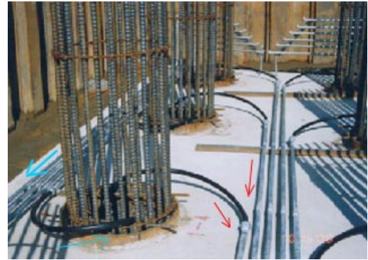
Fig.16 Travaux sous une butée
