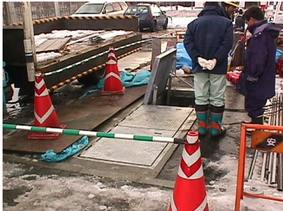
Construction du bac à fondre les neiges
