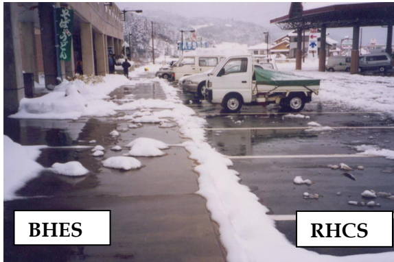
Photo. 3 Conditions de fonte de neige sur le parking qui se relie au système RHCS (21 janvier 2000)
