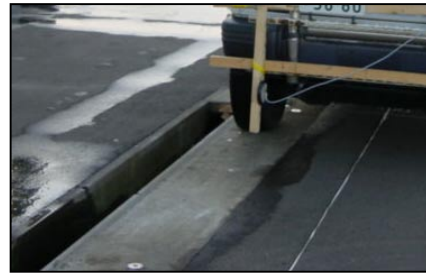
Photographie 5-1-3 Détection des câbles latéraux
