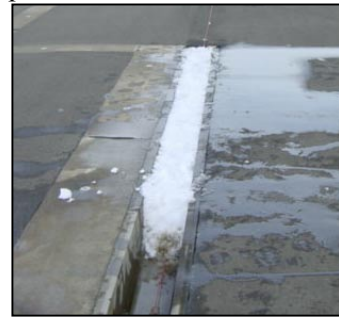
Photographie 5-1-4 Câble transmettant les signaux recouvert de neige
