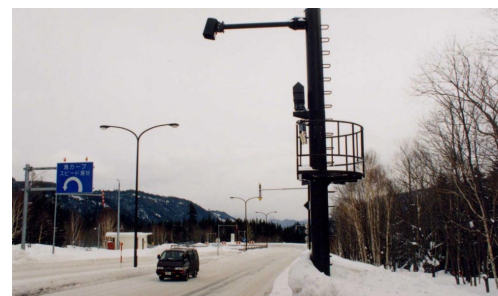
Fig. 3. Points d'observation d'une route ordinaire A partir du haut, appareil de mesure du verglas, caméra de surveillance, radiomètre pour la température de la chaussée et anémomètre.
