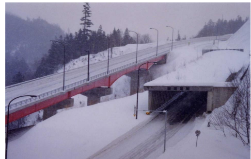
Fig. 2. Points d'observation au pont d'Akaiwa-bashi bridge et sur la route sous abri de Sekihoku sur la R 39
