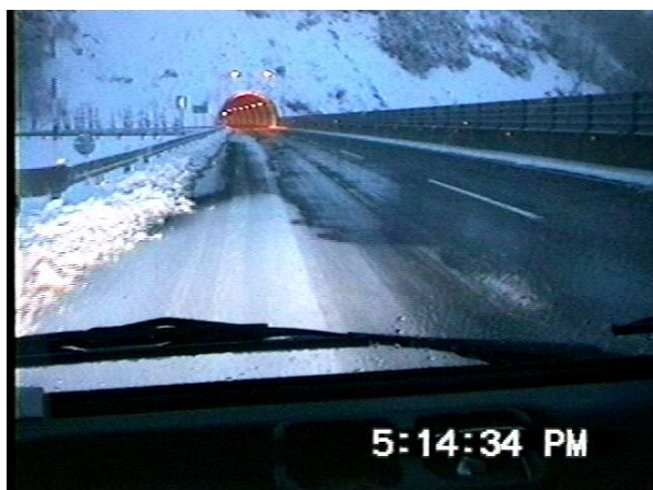
Fonte de la neige par l'arrosage à l'entrée du tunnel Kibuse sur la route montante
