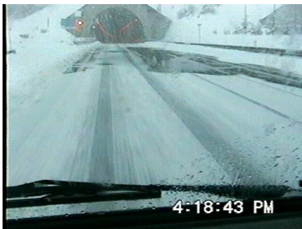
Fonte de la neige par l'arrosage à l'entrée du tunnel Kanayama sur la route descendante
