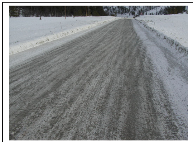
FIGURE 3 Aspect Typique de la Route en de Sable Humidifié Chaud et un Distributeur à Rouleaux.
