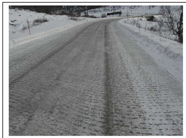
FIGURE 4 Aspect Typique de la Route en Utilisant du Sable Humidifié Chaud et une Centrifugeuse.
