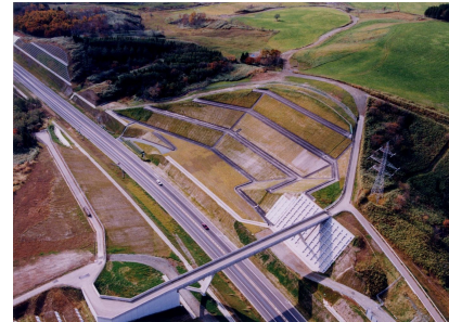
Figure 3 Glissement de terrain (après la reconstruction)
