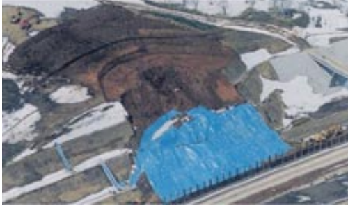
Figure 2 Site du glissement de terrain (en construction)
