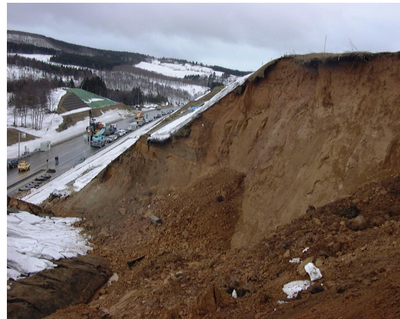
Figure 19 Site du glissement de terrain et zone de drainage
