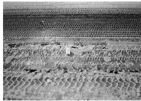
Neige compactée sur le revêtement en PARP
